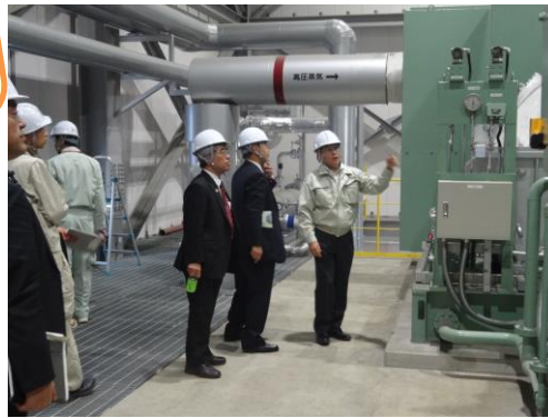
●11/4 大野市木質バイオマス発電 昨年4月稼働、発電規模：7,000 kW 間伐材等を 年間 12 万㎡ 使用
