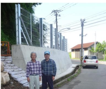
● 5/9 土砂崩れ擁壁完成 これで、子供たちも安全！
