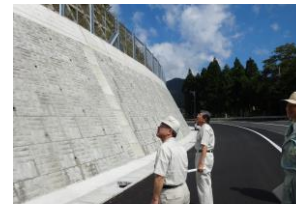
10/1 敦賀、道路改良工事視察
